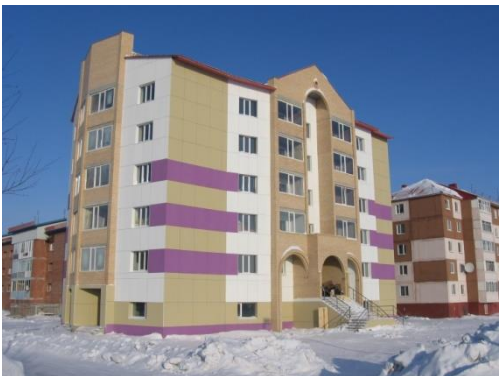
Дом жилой. Г.Губкинский. Фасад. Поставка, монтаж. Заказчик ООО «СУ «Ямал».
